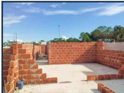
No sistema construtivo de alvenaria estrutural ou autoportante, as paredes possuem função estrutural, ou seja, nesse sistema as paredes suportam os pesos (cargas) da casa toda, incluindo lajes, telhados e esquadrias, e distribuem para as fundações dispensando a construção de vigas e colunas.
